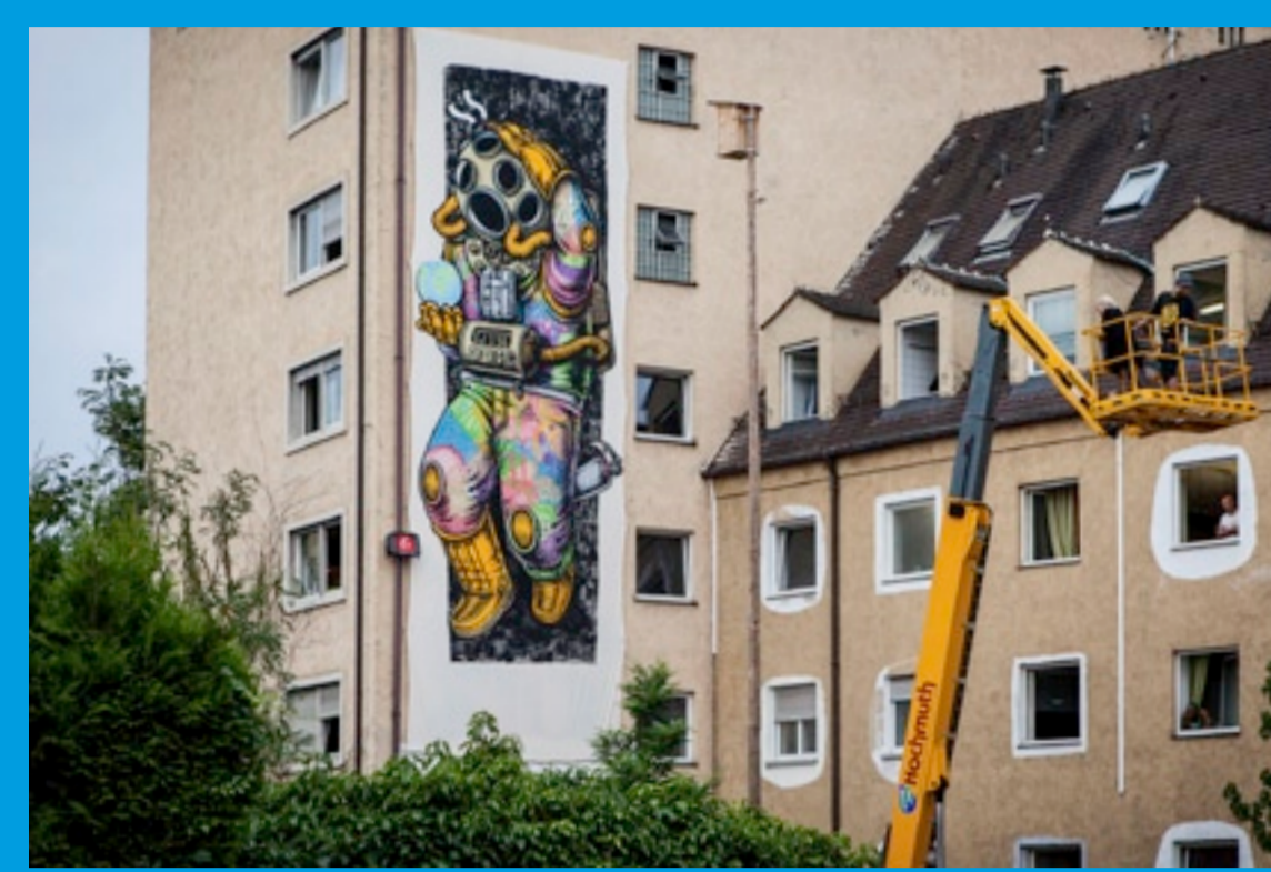
03 Umbau im (an-)laufenden Betrieb
