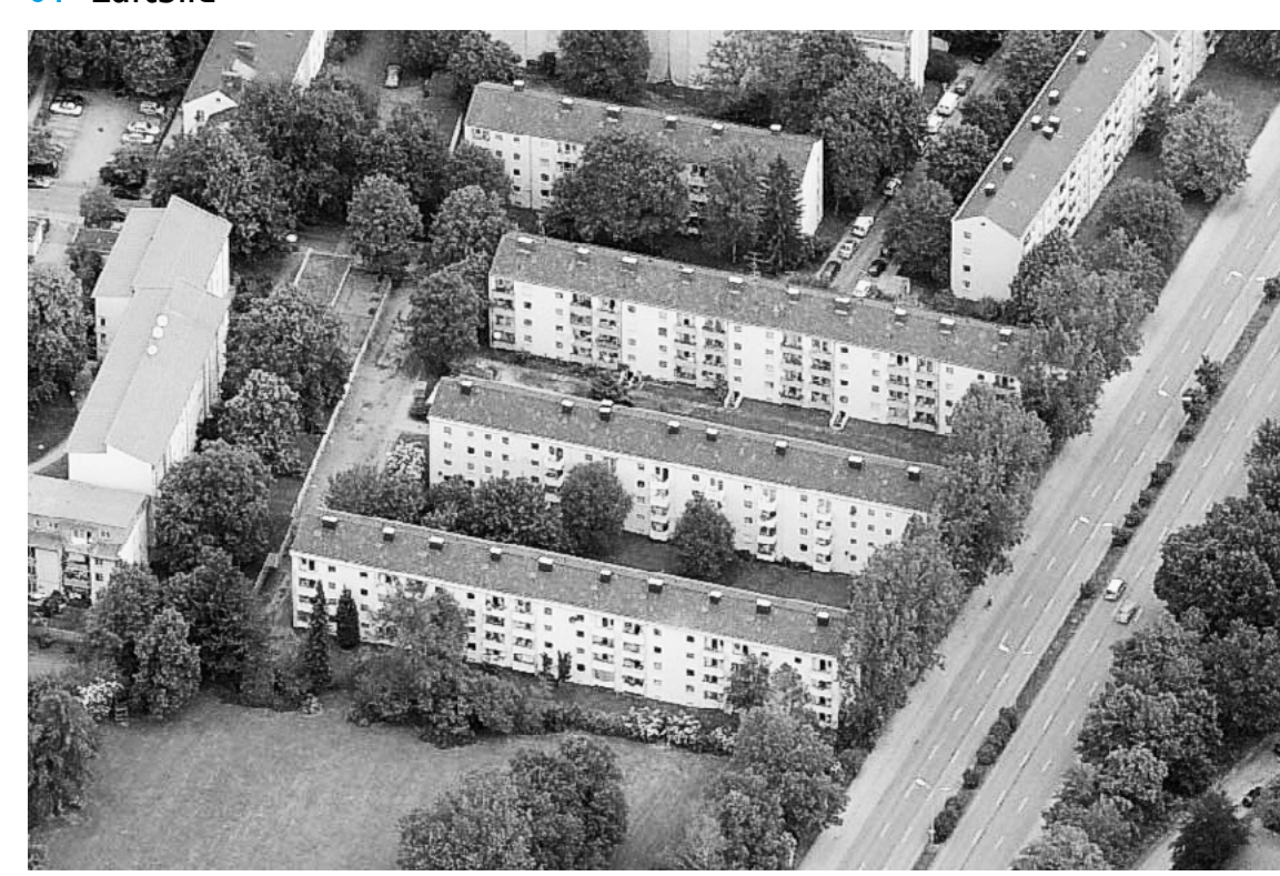
02 Schrägluftbild vor der Modernisierung
