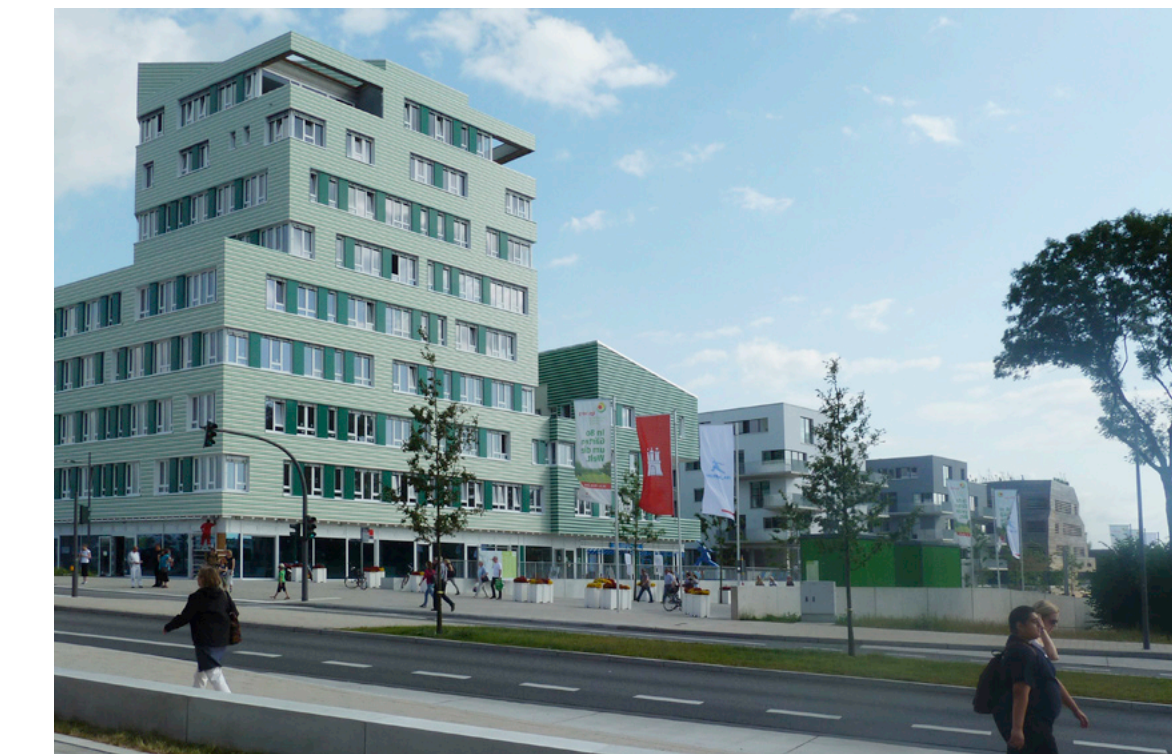
08 Bebauung der IGS-Passage, BOLLES + WILSON
