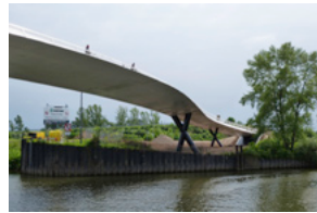
04 Blick auf Ölhafenbrücke nach Westen
