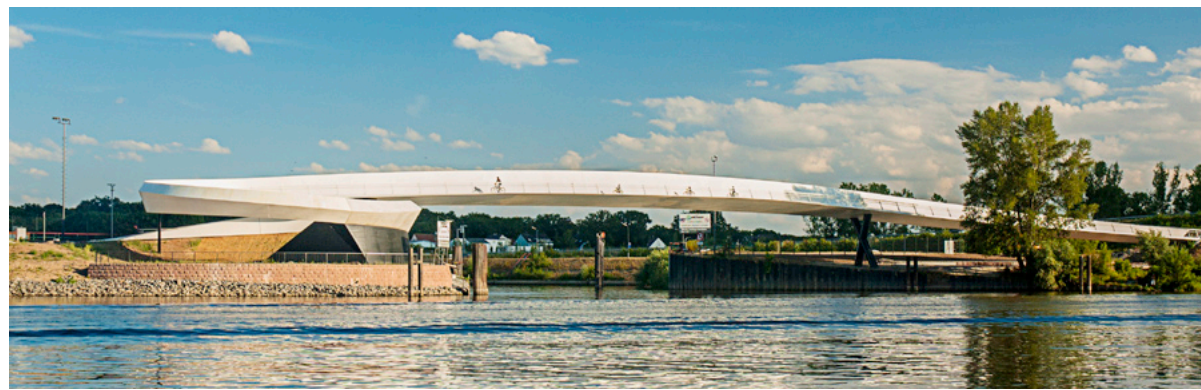
01 Ölhafenbrücke, Ansicht vom Main
