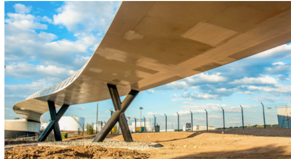
02 Ölhafenbrücke, Unteransicht Überbau mit X-Strützen
