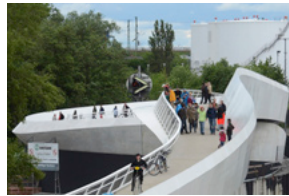
05 Ölhafenbrücke von Westen
