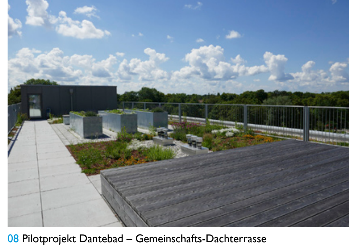
08 Pilotprojekt Dantebad – Gemeinschafts-Dachterrasse
