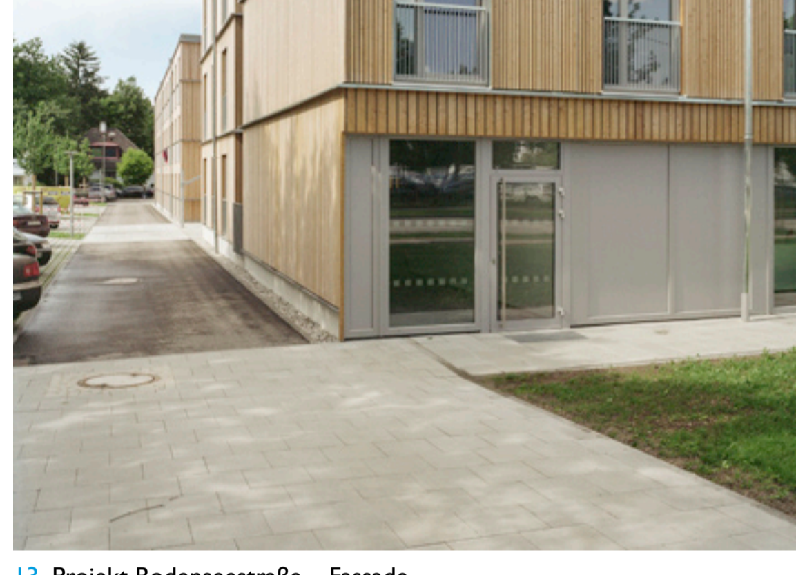
13 Projekt Bodenseestraße – Fassade
