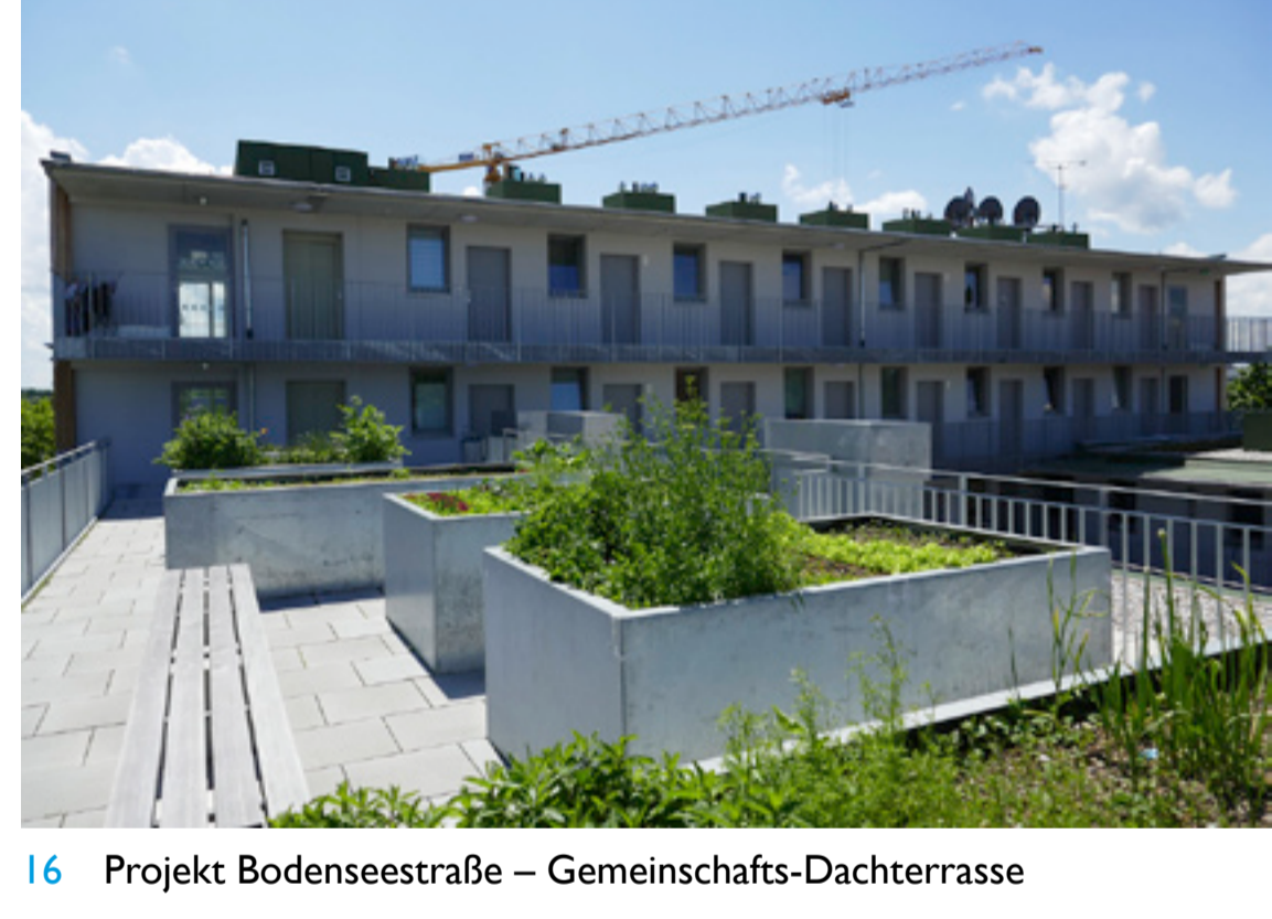
16 Projekt Bodenseestraße – Gemeinschafts-Dachterrasse
