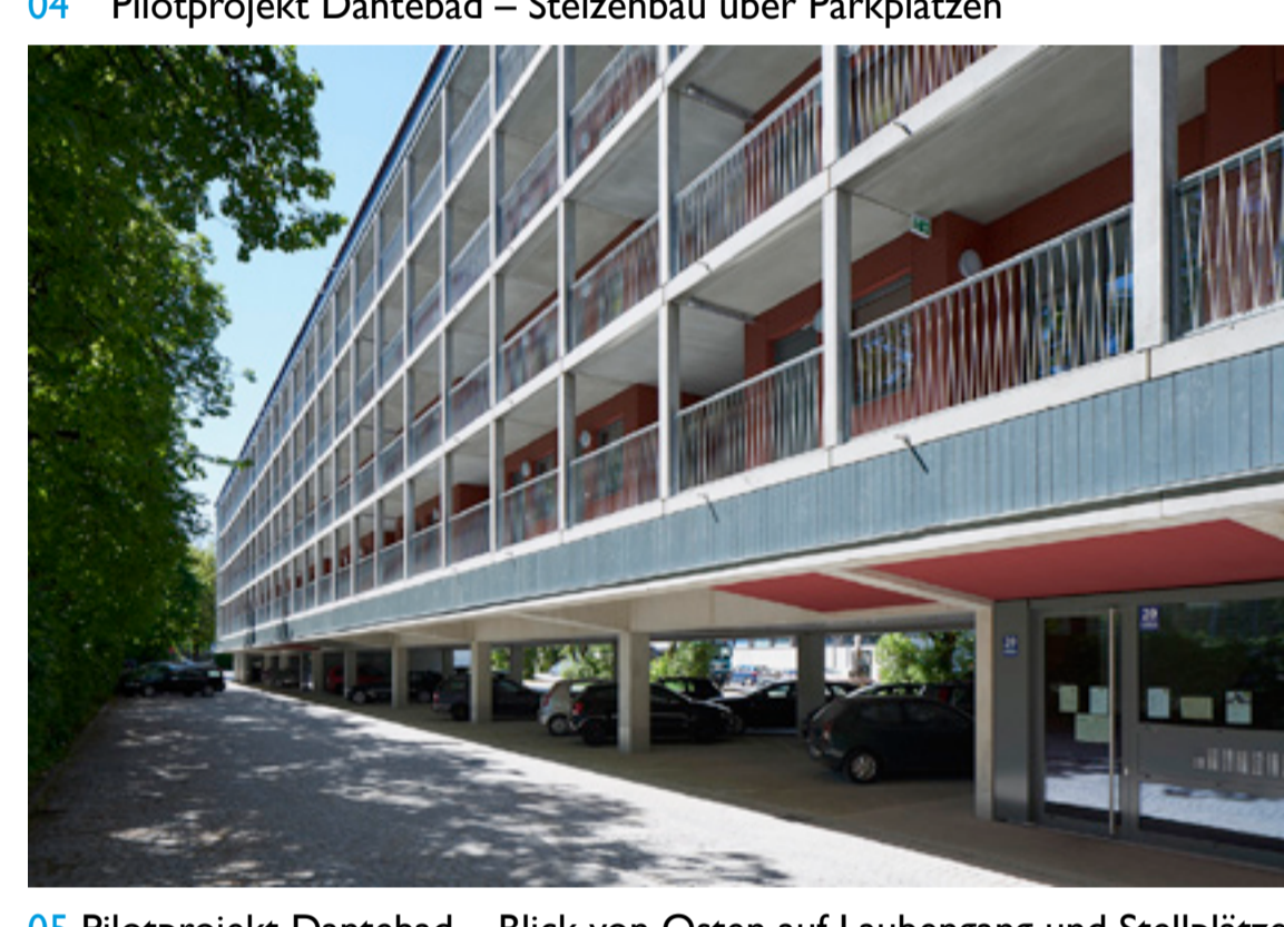
05 Pilotprojekt Dantebad – Blick von Osten auf Laubengang und Stollplätze
