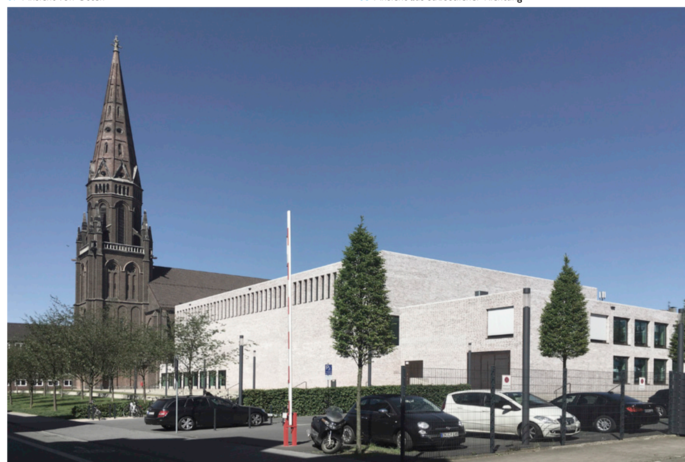
10 Ansicht von der Humboldtstraße aus südwestlicher Richtung
