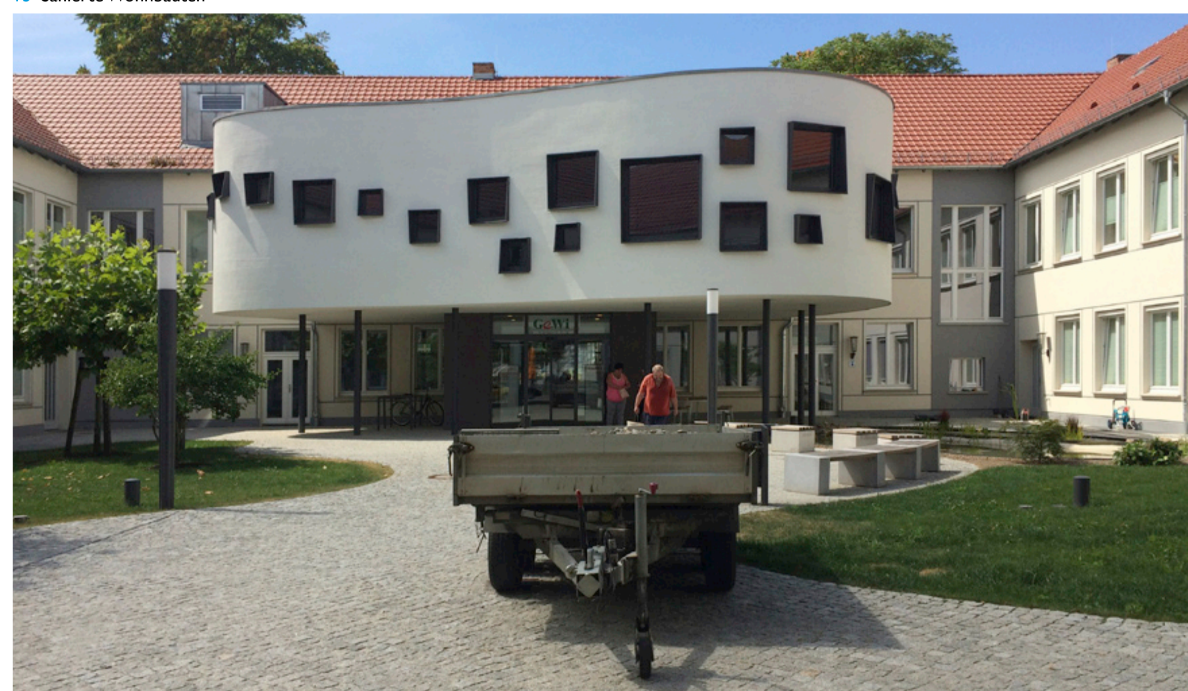
16 Gebäudesanierung und -erweiterung durch die GeWi (Eisenhüttenstädter Gebäudewirtschaft GmbH)
