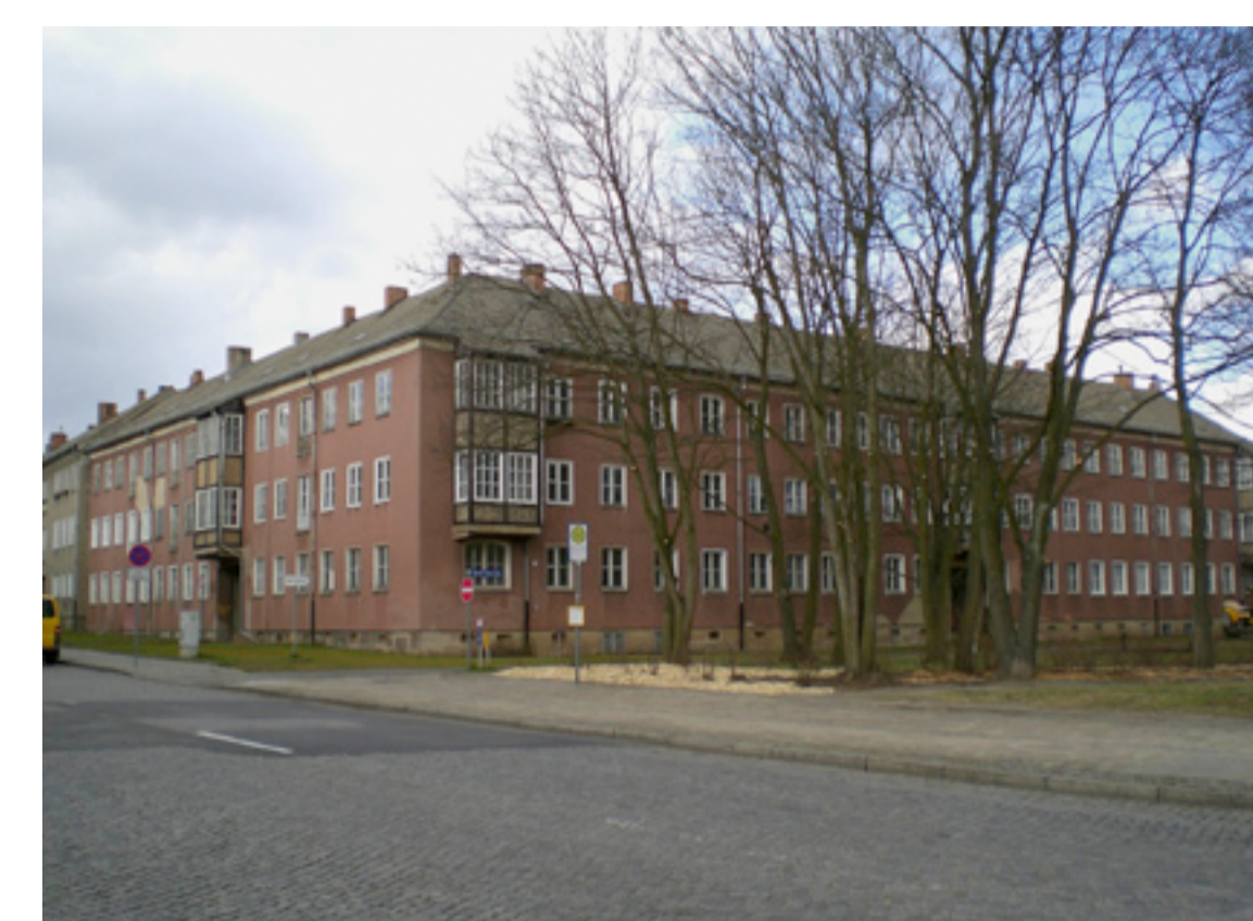
04 Beispiel Wohngebäude im WK III vor der Sanierung
