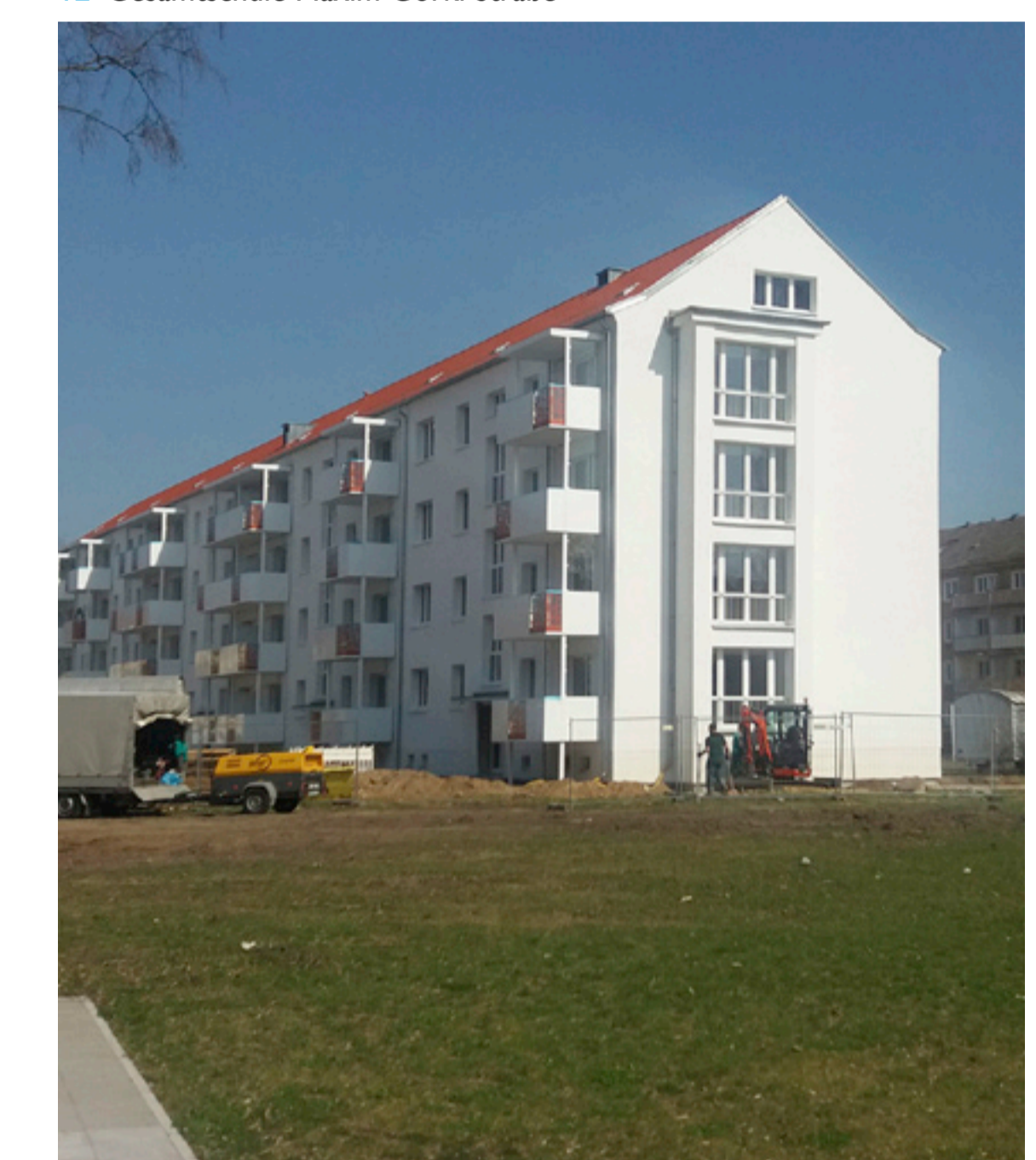
15 Sanierungsprojekt WK IV Friedensweg
