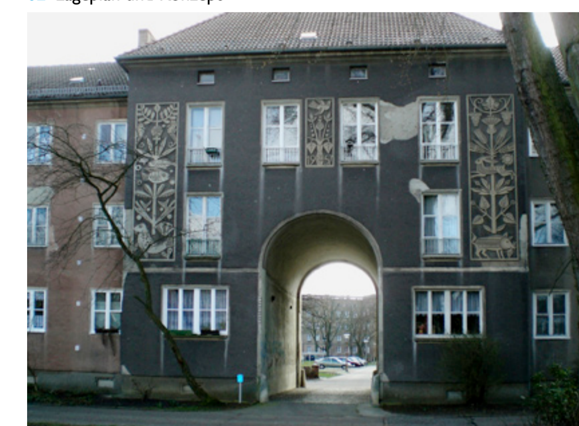
05 Beispiel Wohngebäude im WK III vor der Sanierung
