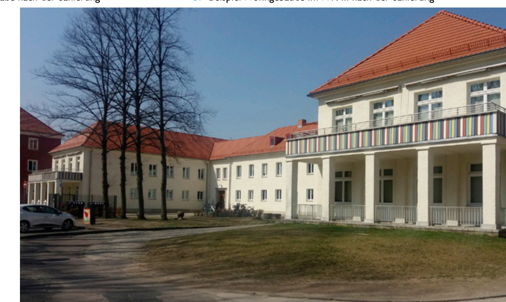
11 Kindertagesstätte Heinrich Heine Allee nach der Sanierung
