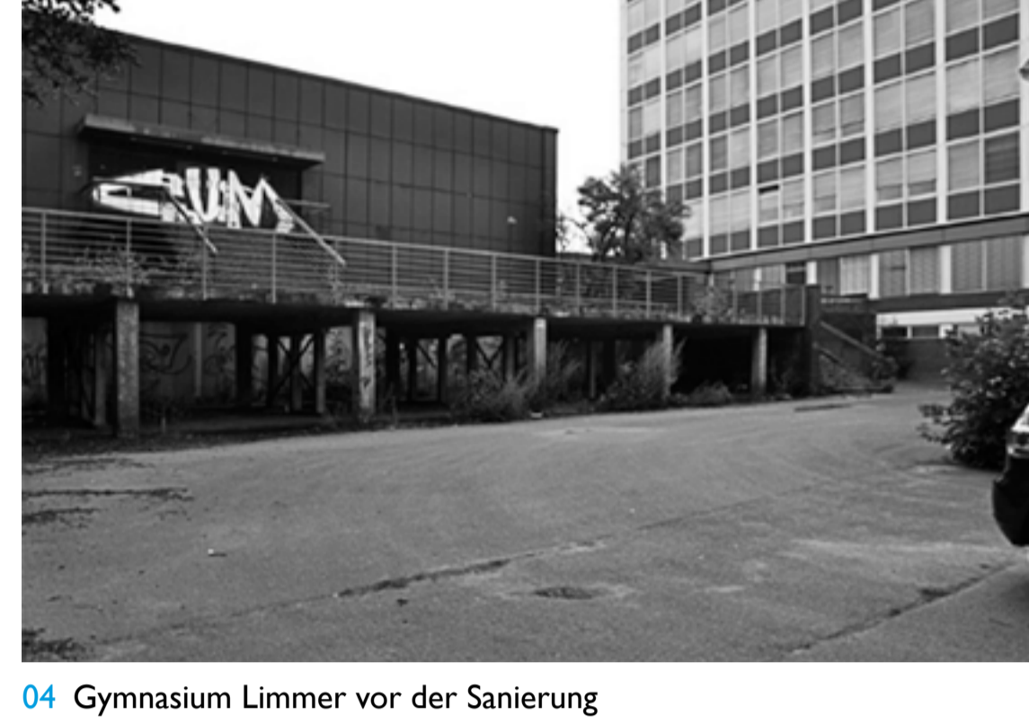
04 Gymnasium Limmer vor der Sanierung
