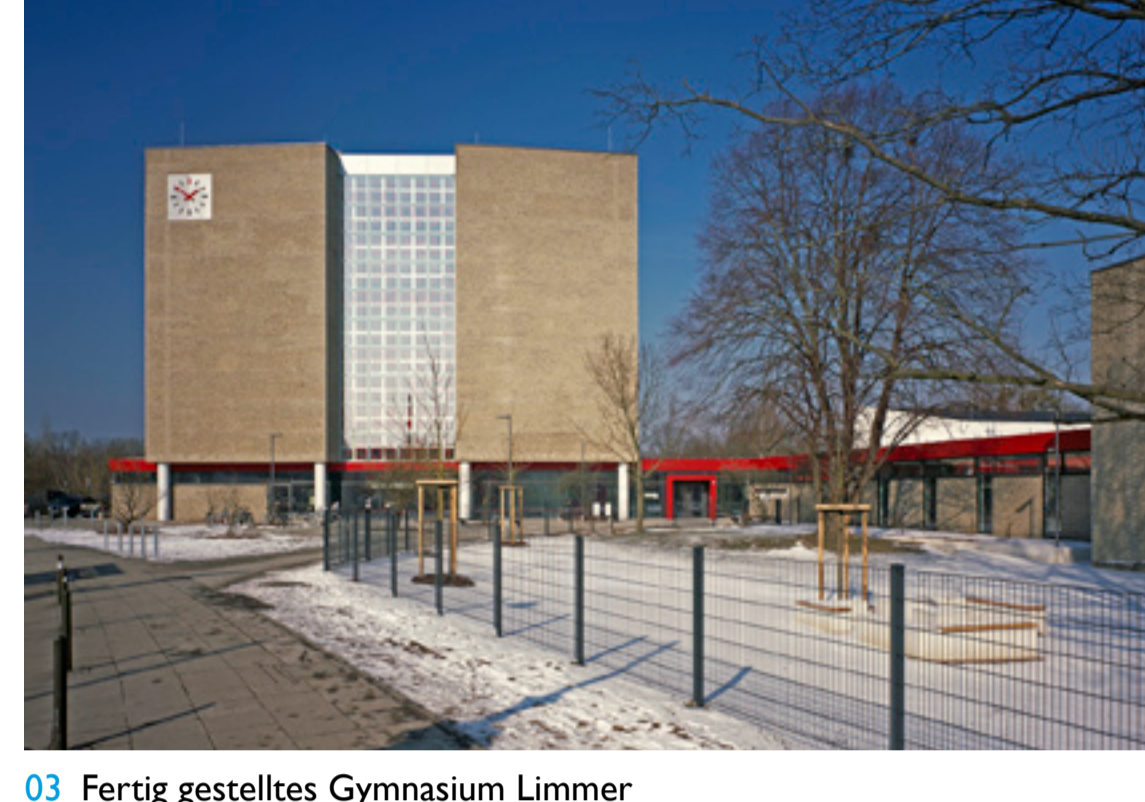
03 Fertig gestelltes Gymnasium Limmer
