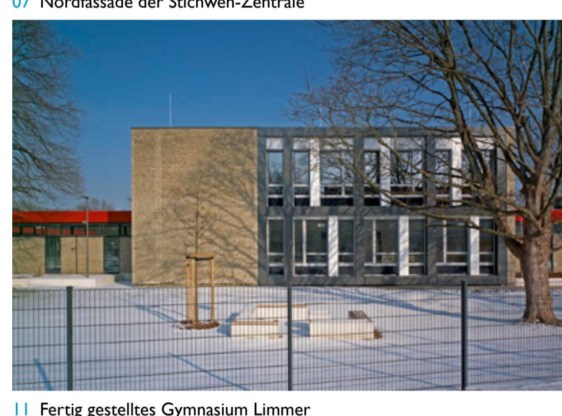
11 Fertig gestelltes Gymnasium Limmer
