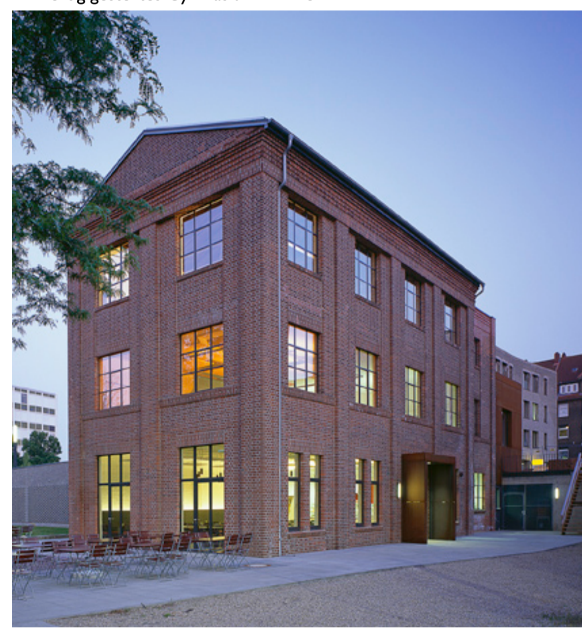
13 Nordfassade der neuen Schwanenburg mit vorgelagerter Terrasse
