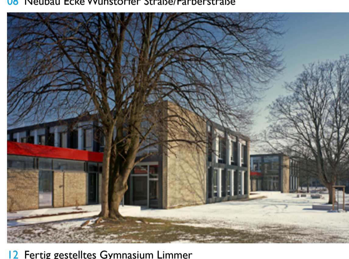
12 Fertig gestelltes Gymnasium Limmer
