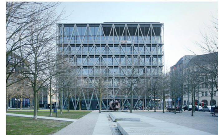
19 taz Neubau, Ansicht Besselpark
