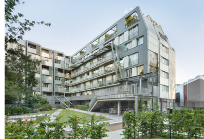
15 Metropolenhaus, Ansicht Besselpark/Gartenfassade
